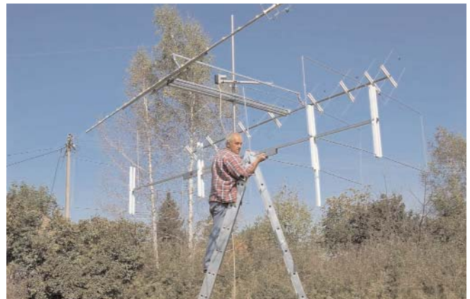
Slika 4. – Postavljanje antenskoga sloga na stup
