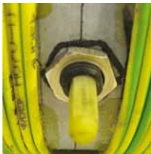
Slika 7. Izlaz osovine variometra
