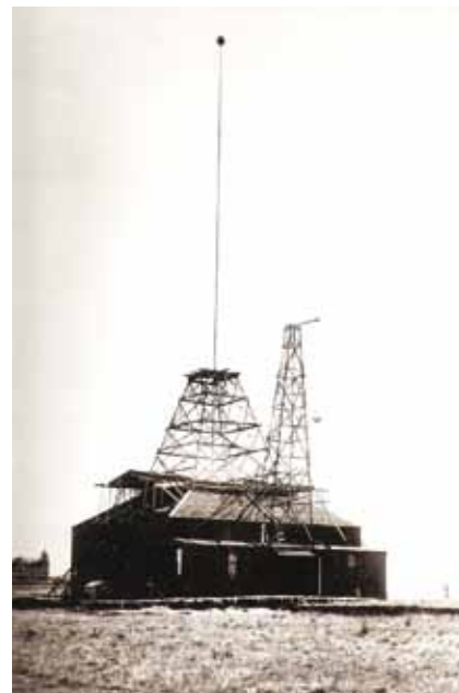
Slika 2. Teslina antena u Coloradu Springsu za odašiljanje elektromagnetskih valova u svrhu bežičnoga prijenosa električne energije i signala, prepoznatljiva i u našoj suvremenoj vertikalki.
