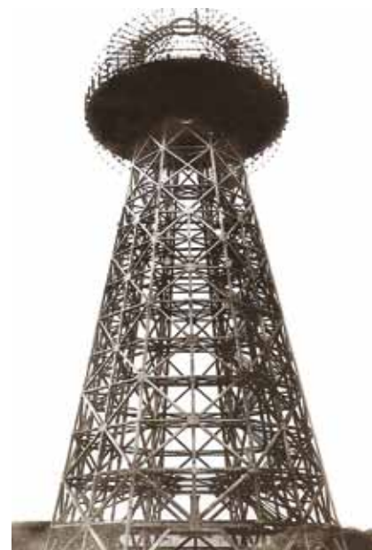
Slika 3. Teslina antena na Long Islandu za velebrno zamišljen, ali neostvaren svjetski sustav prijenosa energije i informacija; visoki antenski stup i danas je želja mnogih radioamatera.
